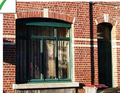
Volets roulants à lames horizontales peintes, installés sur les baies du rez de chaussée donnant sur rue, respectant les linteaux cintrés (butée en partie centrale du volet) dont le coffret est invisible depuis l'extérieur
