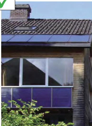
Panneaux discrets en haut de toiture et sur auvent
