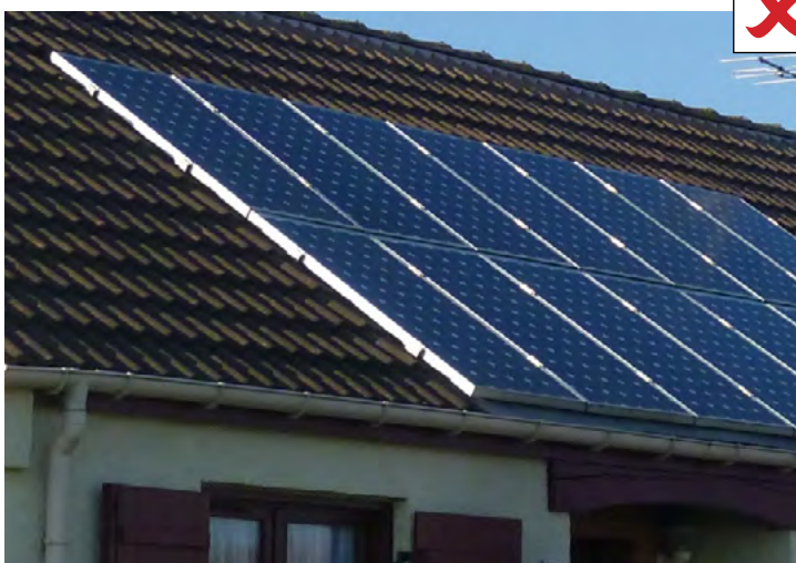
Panneaux non encastrés, bleus, polycristallins, cadre visible
