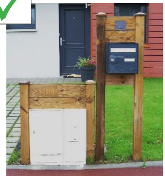
muret technique en bois intégrant les coffrets des concessionnaires et la boîte aux lettres. Jardinet avec un espace de stationnement en pavés avec joints enherbés perméables plus qualitatif de que l'enrobé et un espace enherbé
