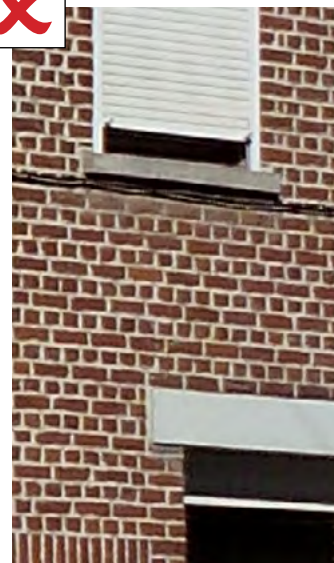
Joints élargis beurrés à fleur et de teinte trop claire : donnent un effet de résille
