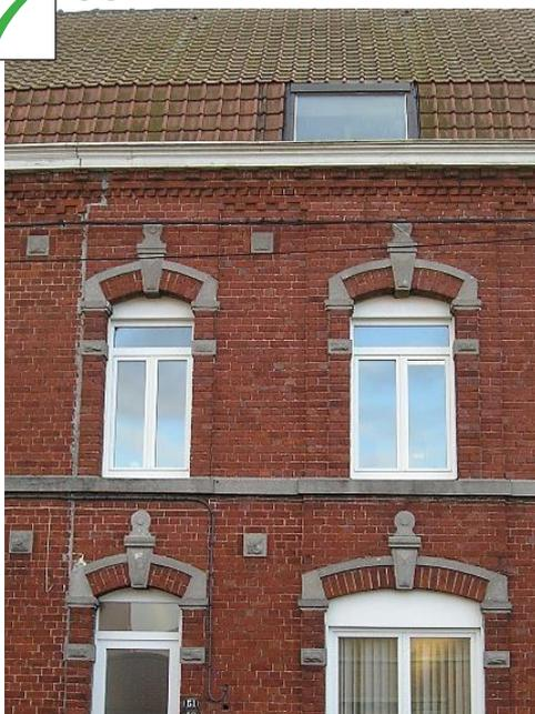
Jointes discretes, ton sur ton par rapport à la brique mettant en valeur l'ensemble des décors de façade : cordons, marquage des linteaux cintrés avec clé de voûte, cabochons, etc.
