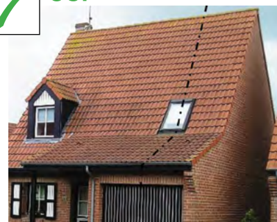
Velux axé sur la porte du garage
