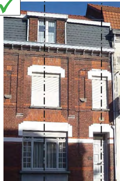
Comble à la mansard habité dont le brisis est en ardoise et le terrasson en tuiles de terre cuite rouge. Fenêtre de toit axée par rapport aux baies de la façade
