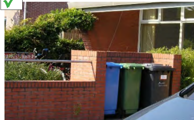
> Murets techniques en brique rouge intégrant boîtes aux lettres, coffrets des concessionnaires et bacs à ordures ménagères
