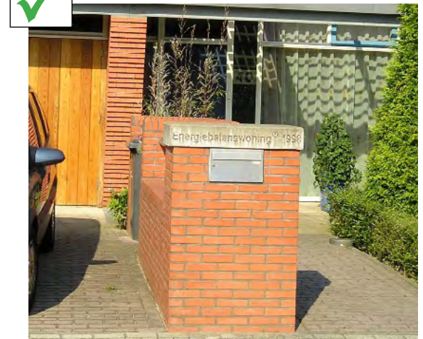
> Murets techniques en brique rouge intégrant boîtes aux lettres, coffrets des concessionnaires et bacs à ordures ménagères
