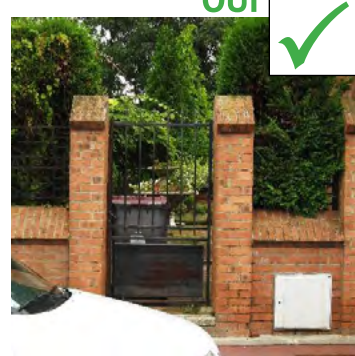
Mur bahut et pieds droits en briques rouges intégrant les coffrets de concessionnaire, avec portillon et barreaudage vertical métallique de teinte sombre, le tout doublé d'une haie végétale
