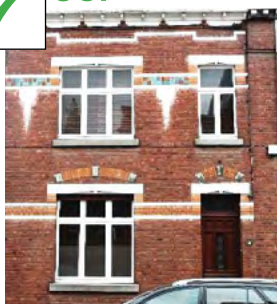
Baies et menuiseries et compartimentage du vitrage axés verticalement et horizontalement, traverses d'impostes vitrées alignées sur les frises décoratives de la maçonnerie
