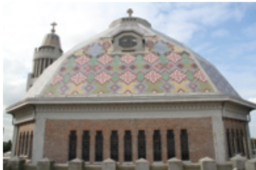
Le dôme de l'église et ses 52 000 carreaux de faïence - © Ville de Comines
