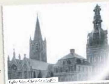
Eglise Saint-Chrysole et beffroi
