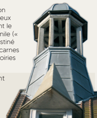
Faux campanile et lucarne de l'Hôtel des postes
